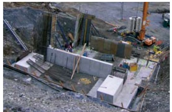
Beeindruckend sind nur schon die Stützenfundamente
