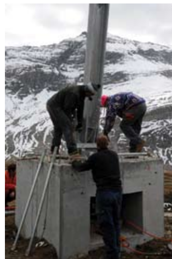
Die Stützenmontage auf der 2. Strecke Ochsenstäfeli - Muttsee ist bereits im Gange
