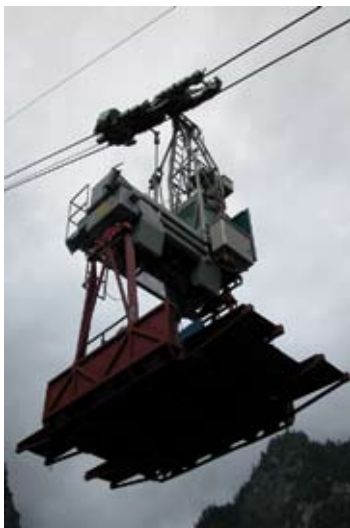
Die 5-Tonnen Windenbahn von Habegger, erbaut 1959, erweist sich heute noch, als zuverlässige Personen- und Transportbahn
