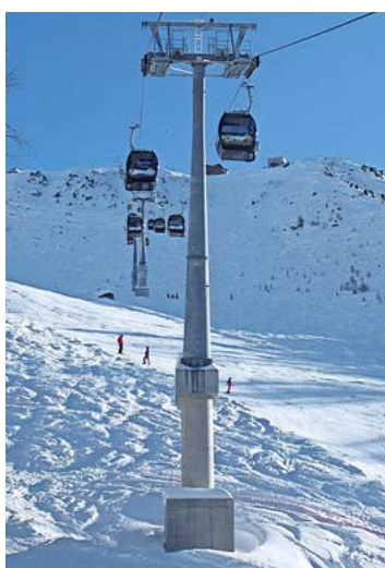
L'élément inférieur de deux pylônes a été réalisé en béton pour assurer une protection contre les avalanches.
