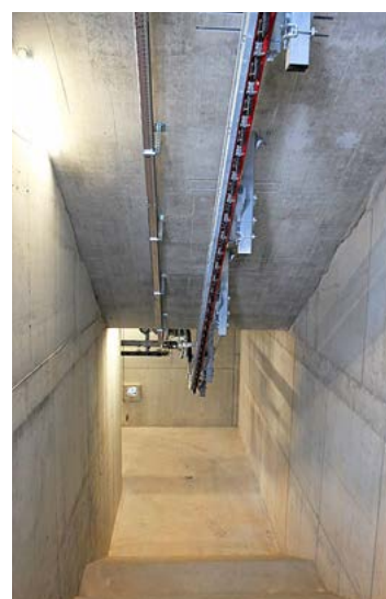
Les 55 gondoles passent la nuit dans la station inférieure de Prarion dans un garage souterrain.
