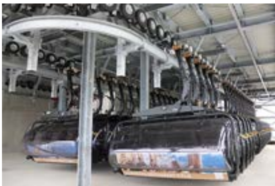
Im Untergeschoss der Bergstation finden 61 Fahrzeuge Platz.
