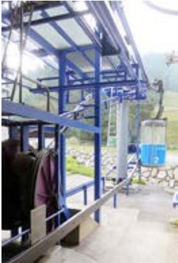
Die Tragseile sind in der Bergstation fix am Poller befestigt, und in der Talstation mit jeweils 13,5 Betonspanngewicht abgespannt.
