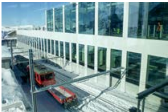
A l'arrière de la station supérieure de l'Eiger-Express a été créée au-dessus d'une nouvelle halle de garage du JungfrauBahn et une salle d'attente moderne.
