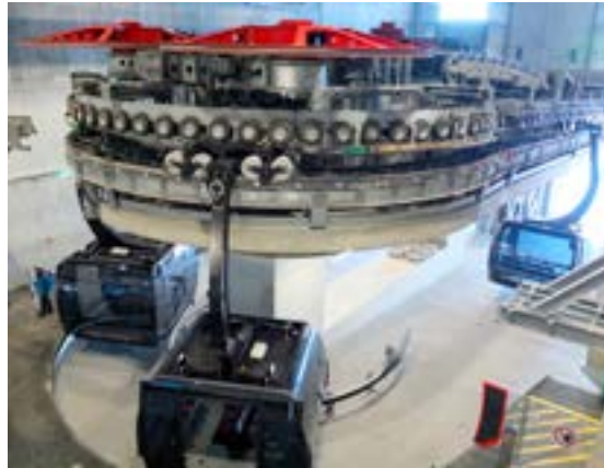
44 Fahrzeuge der CWA ermöglichen eine stündliche Förderleistung von 2200 Personen und dies mit einer Fahrgeschwindigkeit von 8 m/s.
