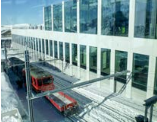
Auf der hinteren Seite der Bergstation des Eiger Express entstand eine neue Einstellhalle für die Jungfrauabahn und darüber ein moderner Aufenthaltsraum.
