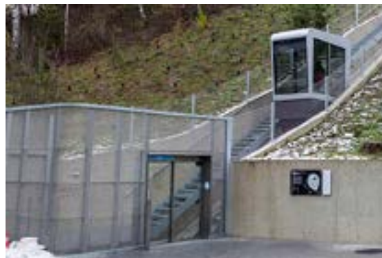
Eine automatische Niveau-Nivellierung gewährleistet eine permanente horizontale Bodenebene.
