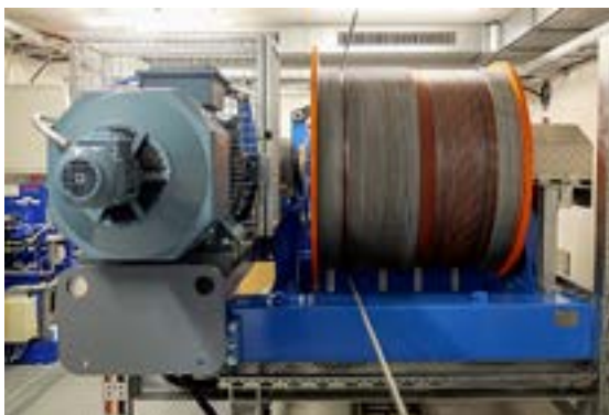
Der Antrieb der Windenstandseilbahn befindet sich in der Bergstation.
