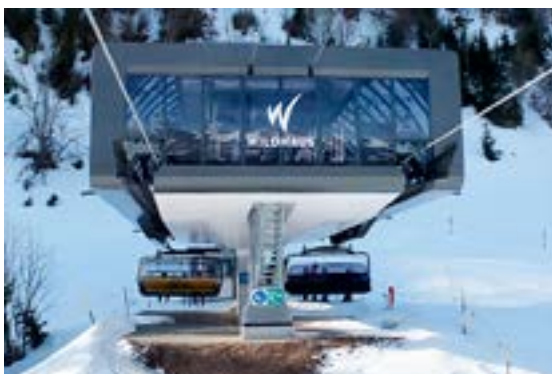
Erst nach der Stationseinfahrt am Berg werden die Schliessbügel entriegelt und automatisch geöffnet.
