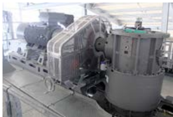
Der Antrieb mit dem ABB Motor und das Getriebe von Doppelmayr/Garaventa befindet sich in der Talstation.
