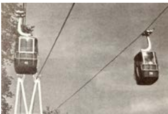
Zur Gartenbauausstellung in Zürich erstellte Habegger 1959 eine kuppelbare Kabinenumlaufbahn mit 4er-Kabinen über den Zürichsee.
