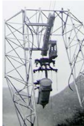
Portalstütze der Schwerlastseilbahn von Biasca zum Wasserschloss.
