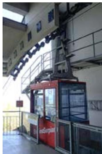
Les selles des câbles sont suspendues à la structure en béton dans la station d'altitude.
