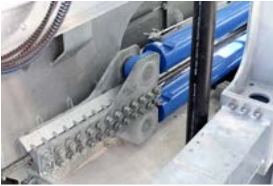
Ein technische Besonderheit, sind die eingebauten hydraulischen Klemmplatten, um die Tragseile in Kürze verschieben zu können.
