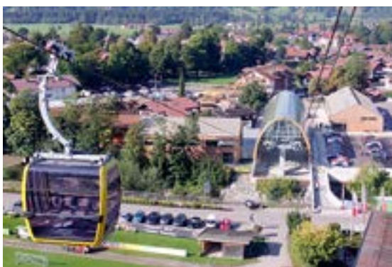
Innert zwölf Monate entstand bei der Talstation ein neues Stations-, Verwaltungs- und Servicegebäude
