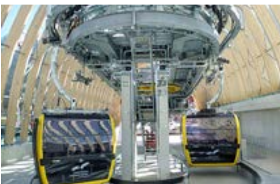
Die moderne Seilbahntalstation wurde vom Architekturbüro Hermann Kaufmann Partner ZT GmbH aus Schwarzach bei Bregenz geplant und bautechnisch umgesetzt.
