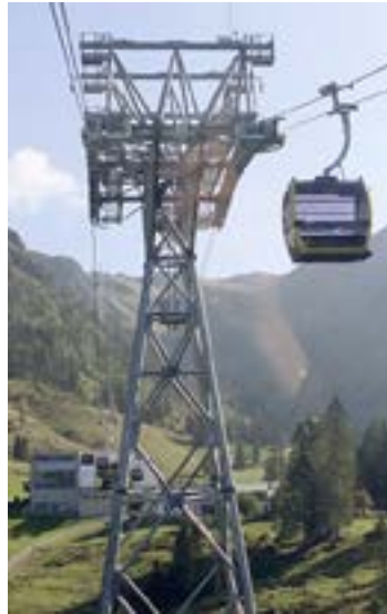
Die Zweiseilumlaufbahn weist auch grosse Stützen auf, wie eine 3-Seilbahn, damit man längere Spannfelder überwinden kann, wie hier vor der Mittelstation Seealpe.
