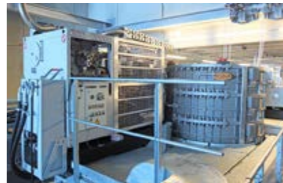
Der Doppelmayr Direct Drive der ersten Sektion ist erstmals weltweit, mit vier Ringen ausgeführt.
