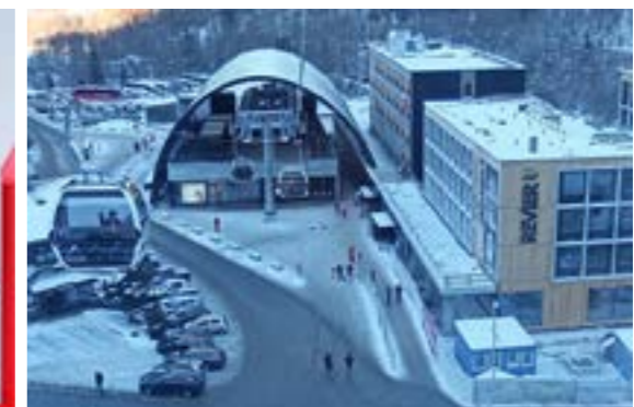
Bei der Talstation ist ein Multifunktionskomplex entstanden. Ab diesem Sommer wird das Hotel Revier eröffnet.
