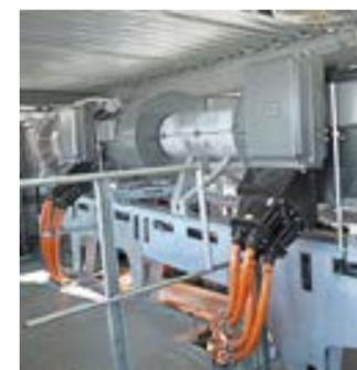
Les deux moteurs d'ABB de la station amont atteignent ensemble une puissance nominale de 930 kW.
