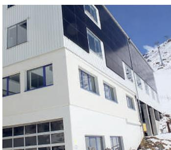
Die PV-Anlage erzeugt rund eine Leistung von 130'000 kWh im Jahr.
