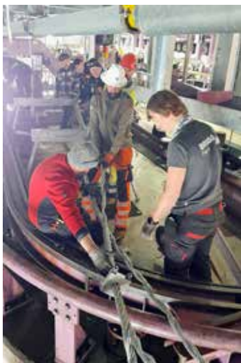
Spleissarbeiten auf dem Arbeitspodest der zweiten Sektion.
