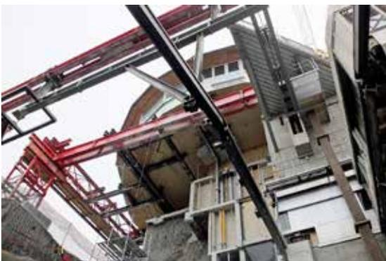
Auf dem Schilthorn 2970 m ü. M. wird das Drehrestaurant abgestützt, um die neue Station erstellen zu können.
