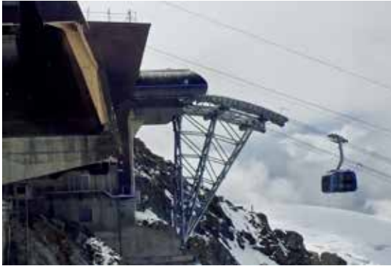
Seit dem 30. Juni 2023 ist die Bergstation Matterhorn Glacier Paradis auf 3883 m ü. M. von zwei 3S-Seilbahnen von Leitner erschlossen. Dort sind auch die Antriebe der beiden Anlagen untergebracht.
