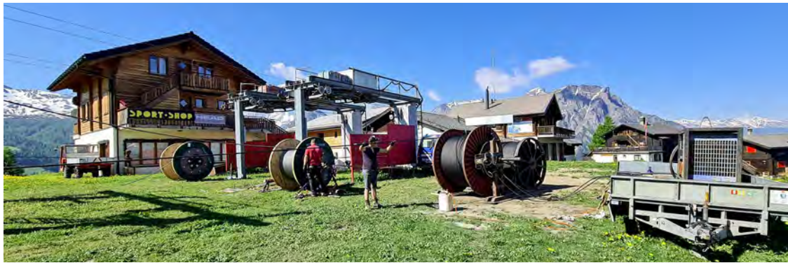
Stefan Halbheer, wechselte in diesem Frühjahr das Förderseil bei einem Skilift der Rosswald Bahnen AG aus.
