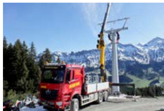
Die Montage der vier neuen Stützen wurde von der Paul Reber AG aus Schüpfheim ausgeführt.
