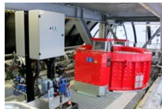
Mit dem EcoDrive kann die Geschwindigkeit automatisch auf den Andrang der Gäste abgestimmt werden.
