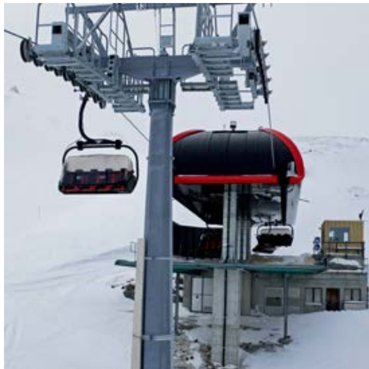
Die neue Sesselbahn von Leitner Stätzertäli kam auf die vorhandene Betonsubstanz zu stehen.
