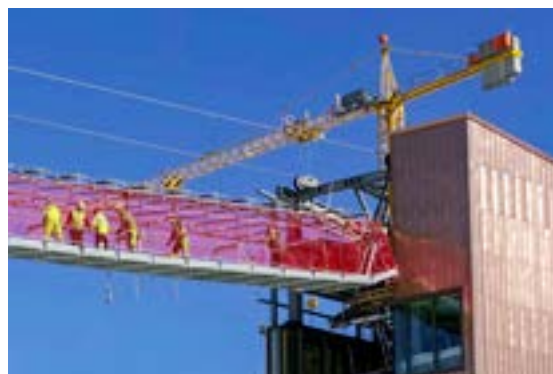
Auf einem Spleissgerüst wurde im Dezember 2024 das Spleissen des Förderseils der ersten Spur für das Funifor auf das Schilthorn bei der Station Birg ausgeführt.
