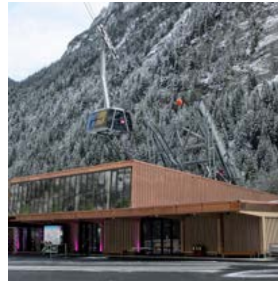
Die neue Pendelbahn fährt in der Talstation direkt durch das Dach.
