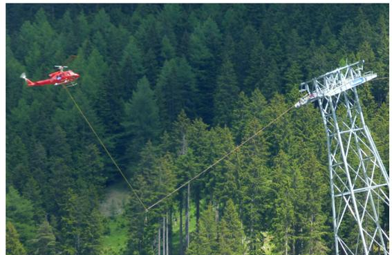
Das Vorseil für den Seilzug wurde mit dem Helikopter von der Bergstation bis zur Talstation gezogen.
