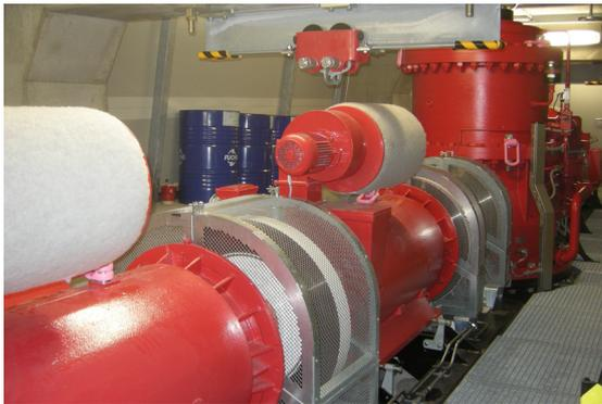
Die vier Motoren der Antriebstechnik in der Bergstation erzeugen eine insgesamt Leistung von 2'080 kW.
