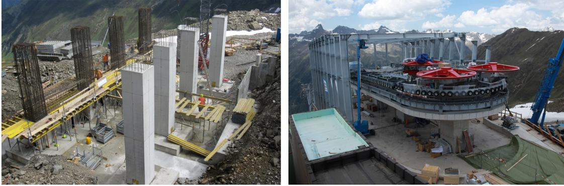
*Dank der Erreichbarkeit mittels Lastwagen bis auf den Pardatschgrat, konnte der Betonbau der Bergstation bereits im November 2013 fertig erstellt werden und im Sommer 2014 die Montage ausgeführt werden.*
