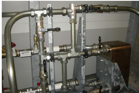
Die Wärme des Getriebes wird mittels Wärmetauscher genutzt und wird zur Beheizung des Pardoramarestaurant genutzt.
