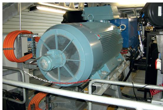
*Der Motor von ABB leistet eine Antriebsleistung von 675 kW.*
