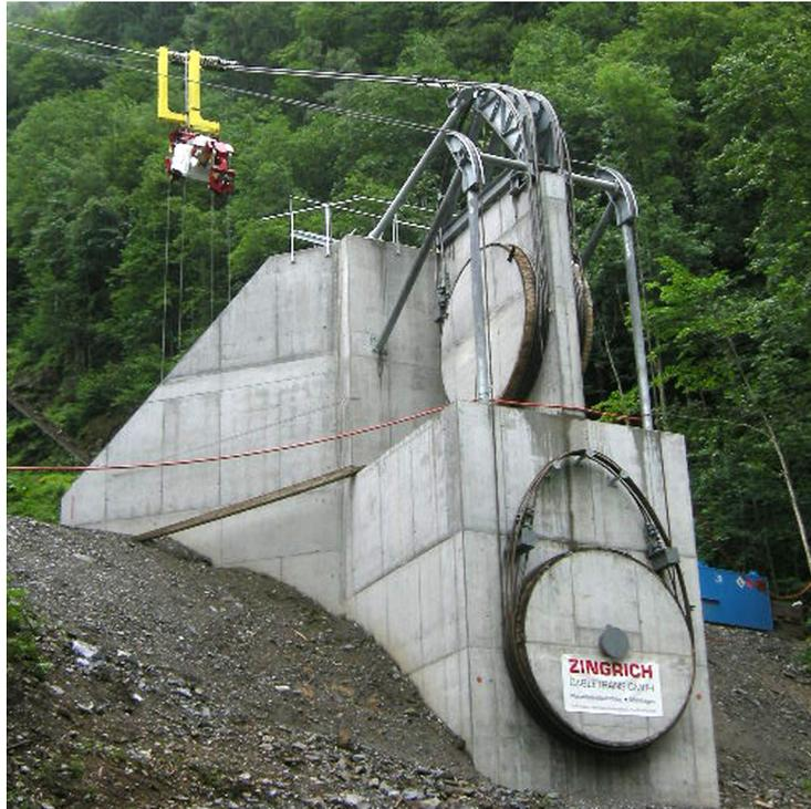
Bis zu 980 Tonnen Beton wurden in der Talstation verbaut.
