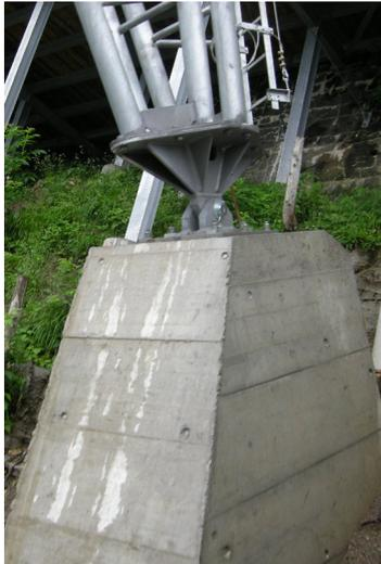
Pro Stützenfuss wurden 6 Anker bis zu einer Tiefe von 12 Metern eingebaut.
