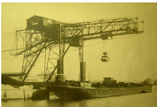
Nebst Seilbahnen baute Bleichert auch Schiffsbeladeanlagen, Kabel- und Brückenkabelkrane, Verladebrücken, Elektrohängebahnen, sowie Werkstätten- und Lagerplatzkrane.
