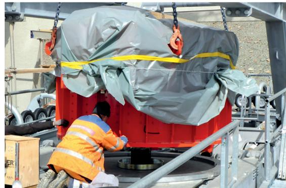
*Die behutsame und präzise Positionierung des DirectDrive, einer zukunftsweisenden Technik, erfolgte durch die Experten des Montageteams von Leitner ropeways.*
