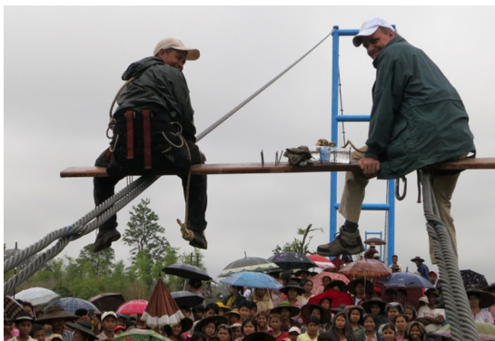
In schwindelerregender Höhe werden die Hängeseile an die Trageile befestigt.
