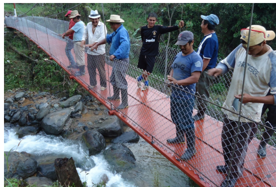
Früher wurde der Boden der Brücke noch mit Holz zusammengestellt, heute ist es verzinktes Riffel-Stahlblech, das mit Rostschutzfarbe behandelt ist.
