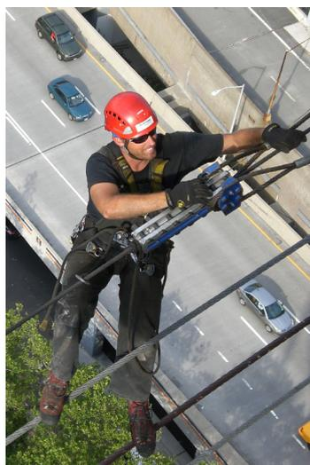
Einsatz in New York für das Ziehen und Spannen der Trag- und Zugseile über die Hauptverkehrsadern der Grossstadt.
