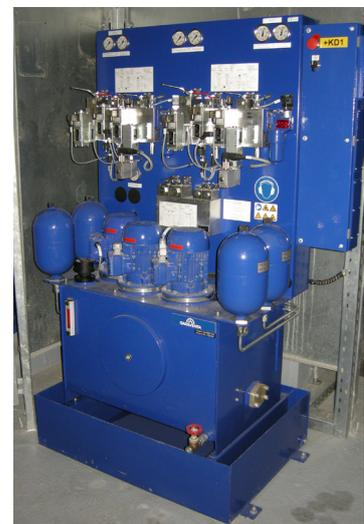
Die Hydraulik ist redundant ausgestattet und kann bei Bedarf von einem System auf das andere System umgeschaltet werden.
