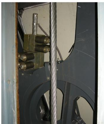
Dank der Trommelseilverankerung am Fahrzeug, kann innert zwei Stunden das Förderseil gekürzt werden.
