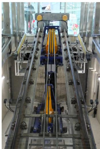
*Des vérins hydrauliques (entraînement de composition) dans la station d'altitude garantissent que les véhicules s'arrêtent toujours dans la position adéquate des stations intermédiaires.*
