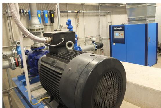
*In der neuen Pumpstation Obersäss sind eine Kreiselpumpe sowie die Luftdruckanlage untergebracht.*
