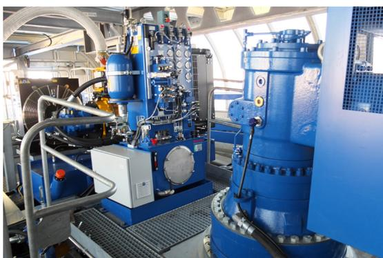
*Beim Antrieb in der Bergstation ist das Hydraulik-Aggregat von Rexroth untergebracht.*
