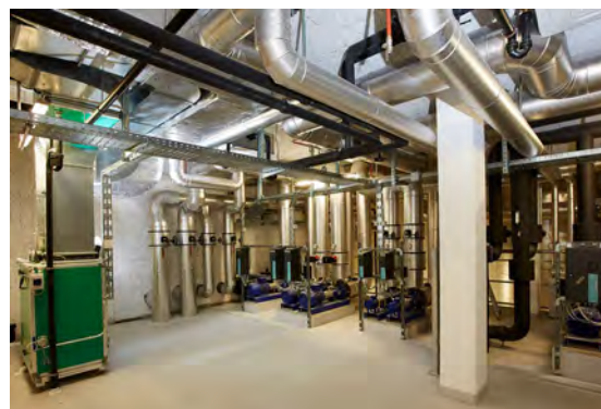
Wärmepumpen erwärmen das Wasser in der Energiezentrale auf 450 bis 550 Celsius und anschliessend wird das Wasser mit Fernleitungen zum Resort gepumpt.
