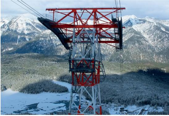
Sur le pylône le plus élevé du monde, la voie s'élève à 18,6 m. A 10 m dans la station inférieure et 12,6 m dans celle supérieure.
