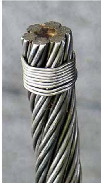
Abb. 4: In einem einlagigen Litzenseil entsteht ein mit der Zugkraft nahezu proportionales Drehmoment.
