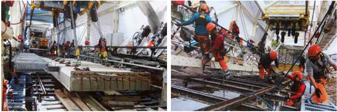
Vom Versetzwagen aus wurde betoniert, die Betonelemente sowie die Schienen eingebaut.
