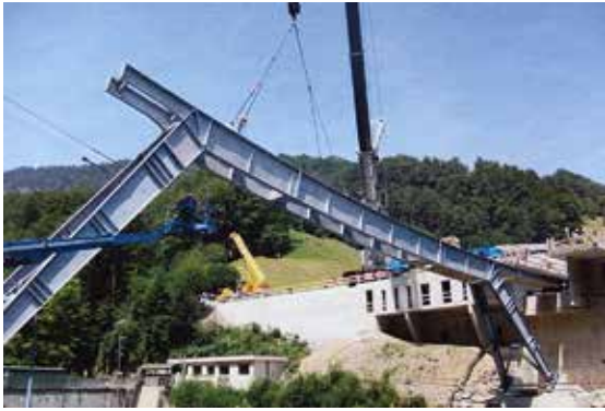
Mit einem der grössten Pneukrane der Schweiz wurde im Sommer 2015 die 150 m lange Stahlbrücke über die Muota aufgebaut.
