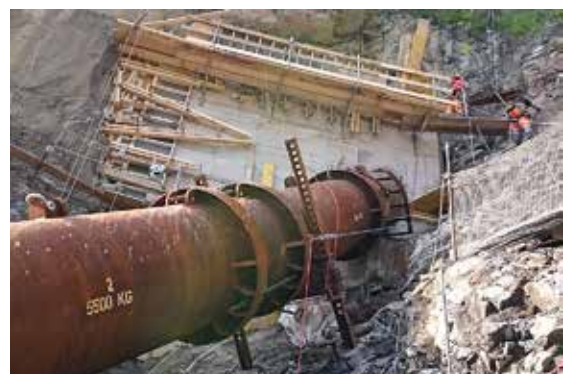
Im untersten Tunnel wurde das Abbruchmaterial durch eine Röhre heruntergelassen.
