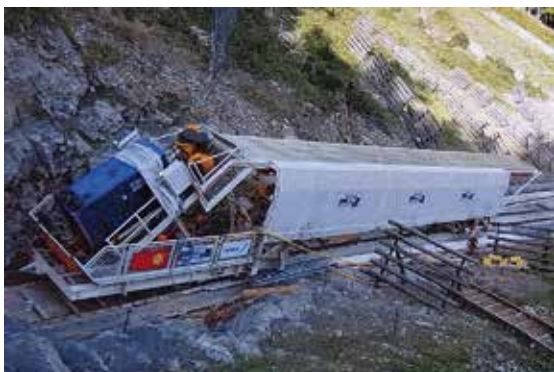
Der mechanisierte Trasseebau benötigte eine eingebaute, verschiebbare Versetzeinrichtung auf einem Wagen, dem ein Transportwagen voraus ging.
