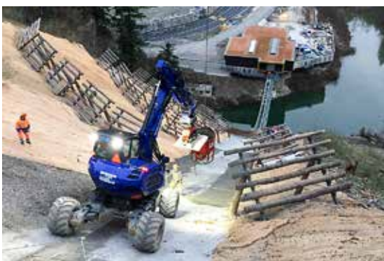
Der Schreitbagger wurde doppelt gesichert, um die Arbeiten auf dem Trasse ausführen zu können.
