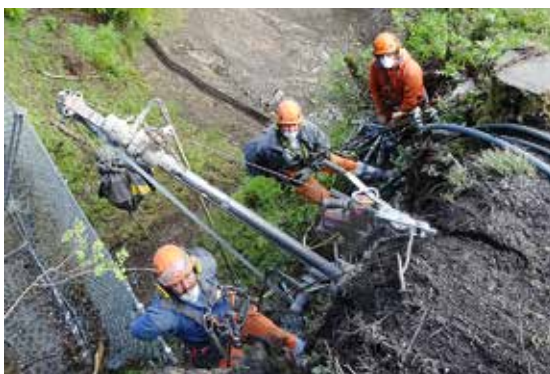
Dank der strengen Anforderungen bei der Arbeitssicherheit konnte die Baustelle ohne grössere Unfälle abgeschlossen werden.
