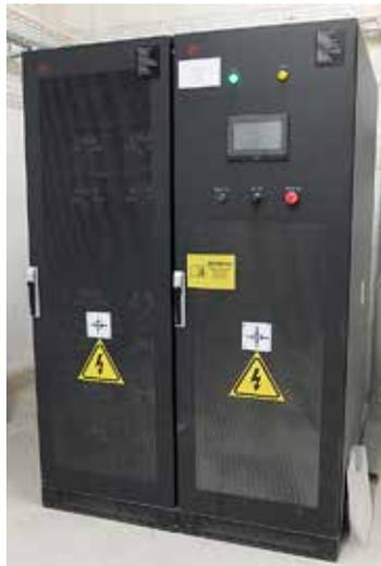
Die gewonnene Sonnenenergie wird in der Talstation in Batterien gespeichert.
