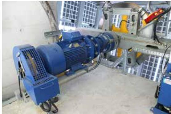
Zwei Motoren mit einer Leistung von jeweils 55 kW erbringen die Antriebsleistung.
