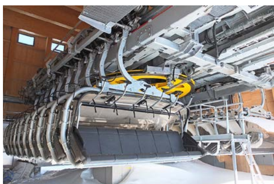
23 Fahrzeuge der Sesselbahn auf den Schneehüenerstock werden in der Bergstation geparkt.
