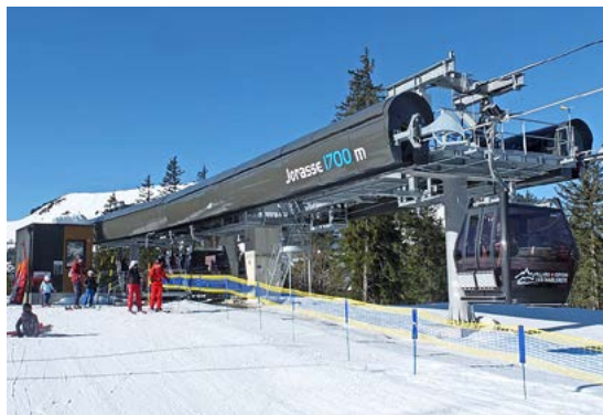
De la station intermédiaire Jorasse, les skieurs parviennent directement aux pistes de ski sophistiquées.
