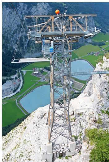
Die Stütze 1 wurde als Zwischenausstieg für die Mitarbeitenden der KLL und für die Äpler errichtet.
