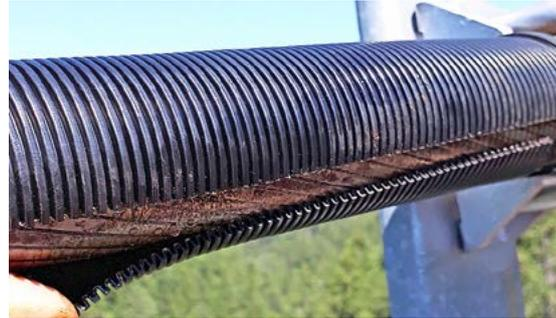
*Bild 6: Mit aufgeschnittenen Kunststoffrohren wollte man die Tragseile einer Brücke vor Korrosion schützen. Weil sich das Seil mit der Zeit verdrehte, lag der Schlitz der Umhüllung nicht mehr unten. Wasser konnte sich ansammeln und das Seil stets feucht halten. (Quelle G. Piskoty).*
