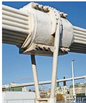
Bild 2: Ein Brückenseil ist vor Korrosion mit einem Anstrich ummantelt.
