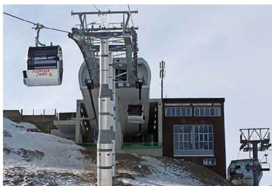
Die neue Bergstation auf Maschgenkamm wurde neben der ehemaligen und leicht gegen das Tal aufgebaut.
