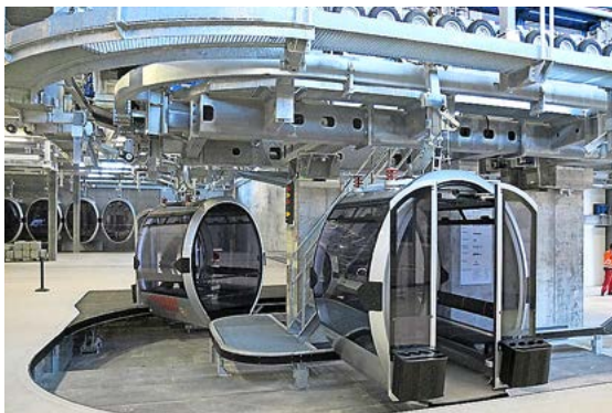
In der Talstation auf Tannenboden werden die 105 Fahrzeuge die im Design by Porsche Design Studio in Flums erstellt worden sind, innert 30 Minuten parkiert.
