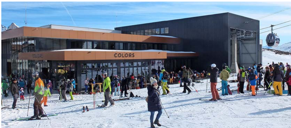
Die neue Talstation Tannenboden, in welcher neben dem neuen Restaurant «Colors» auch noch eine grossräumige Garage für die Pistenfahrzeuge entstand. Bild: Flumserbergbahnen AG
