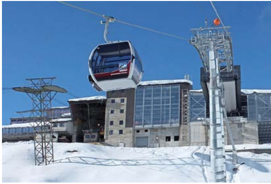
Die Bergstation mit Garagierung wurde in die bestehende Bausubstanz der Station integriert und ergänzt.
